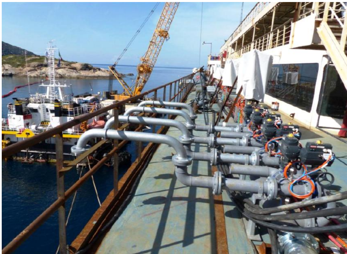
Sopra: Sistema di controllo della zavorra dei cassoni sul ponte 10 della Costa Concordia Sotto: Cassone S12 e S11 a bordo del pontone Micourier 2 a Livorno
