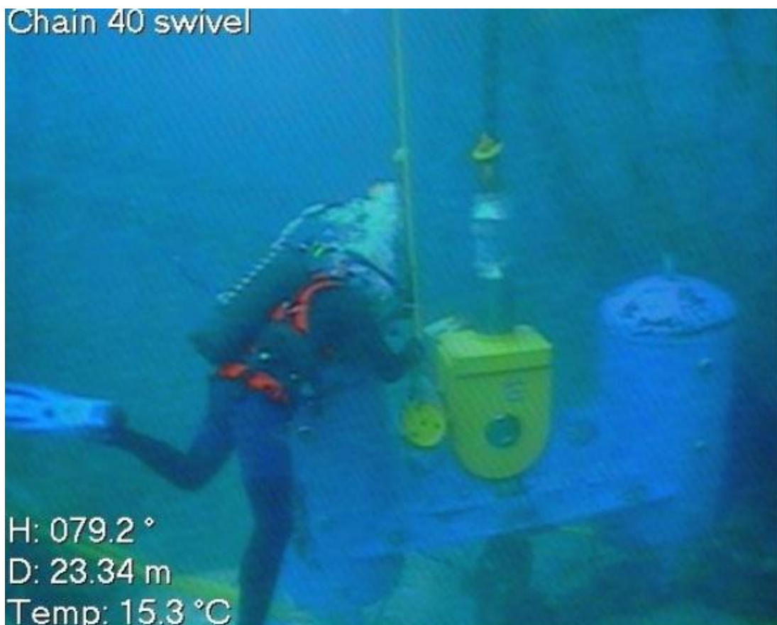
Sopra: installazione rinforzo del ginocchio 48 Sotto: operazioni di connessione catena 40 con swivel pin
