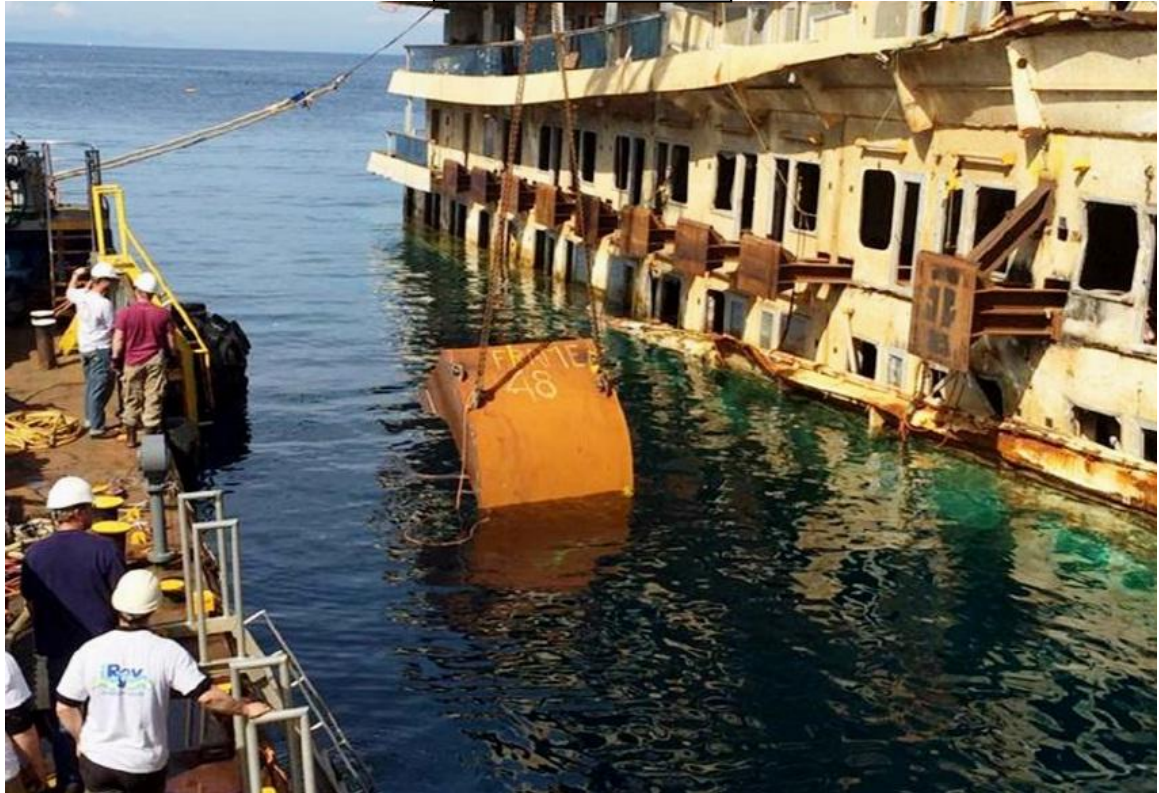
Sopra: installazione rinforzo del ginocchio 48 Sotto: operazioni di connessione catena 40 con swivel pin
