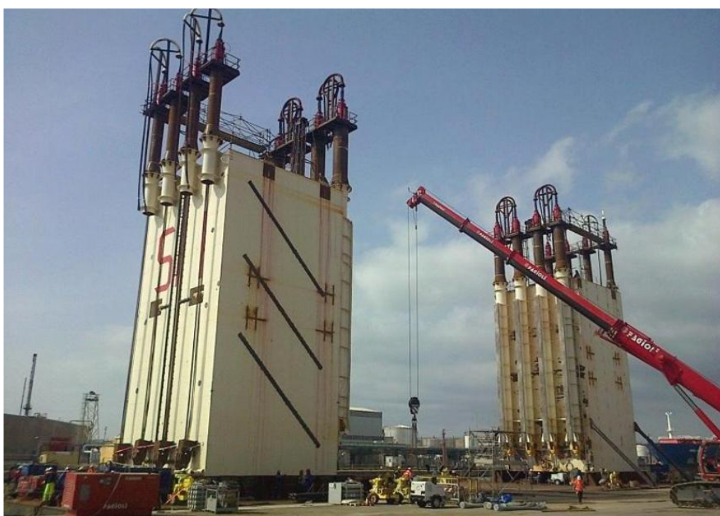
Sopra: Sistema di controllo della zavorra dei cassoni sul ponte 10 della Costa Concordia Sotto: Cassone S12 e S11 a bordo del pontone Micourier 2 a Livorno
