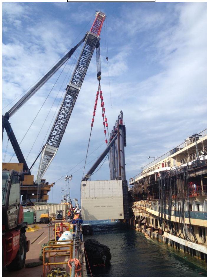
Sopra: installazione cassone di spinta S13.
