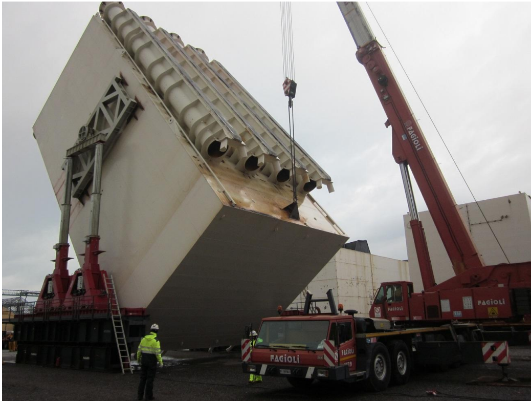
Rotazione del cassone di spinta S12 presso il cantiere di Livorno
