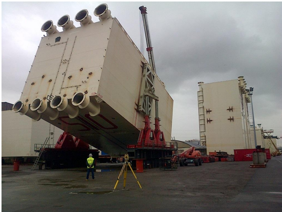
Rotazione del cassone di spinta S10 presso il cantiere di Livorno
