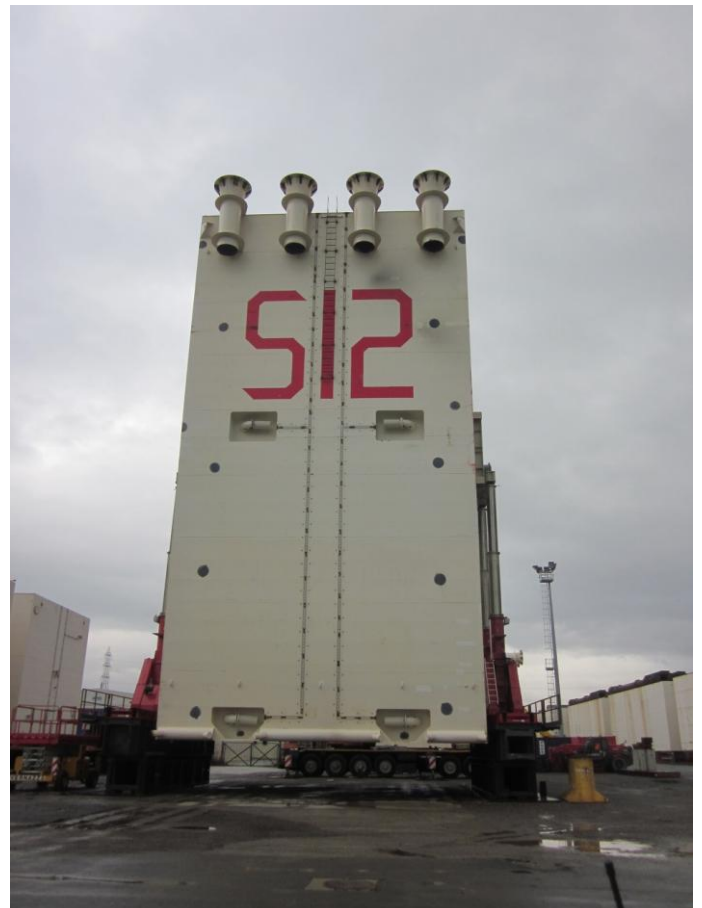
Rotazione del cassone di spinta S12 presso il cantiere di Livorno
