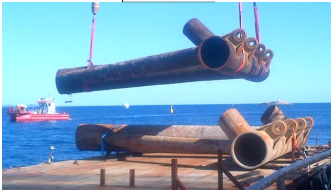
Sopra: Tubolari (pull bars) rimossi dalla piattaforma 3 - Sotto: cassoni S12-S6 installati
