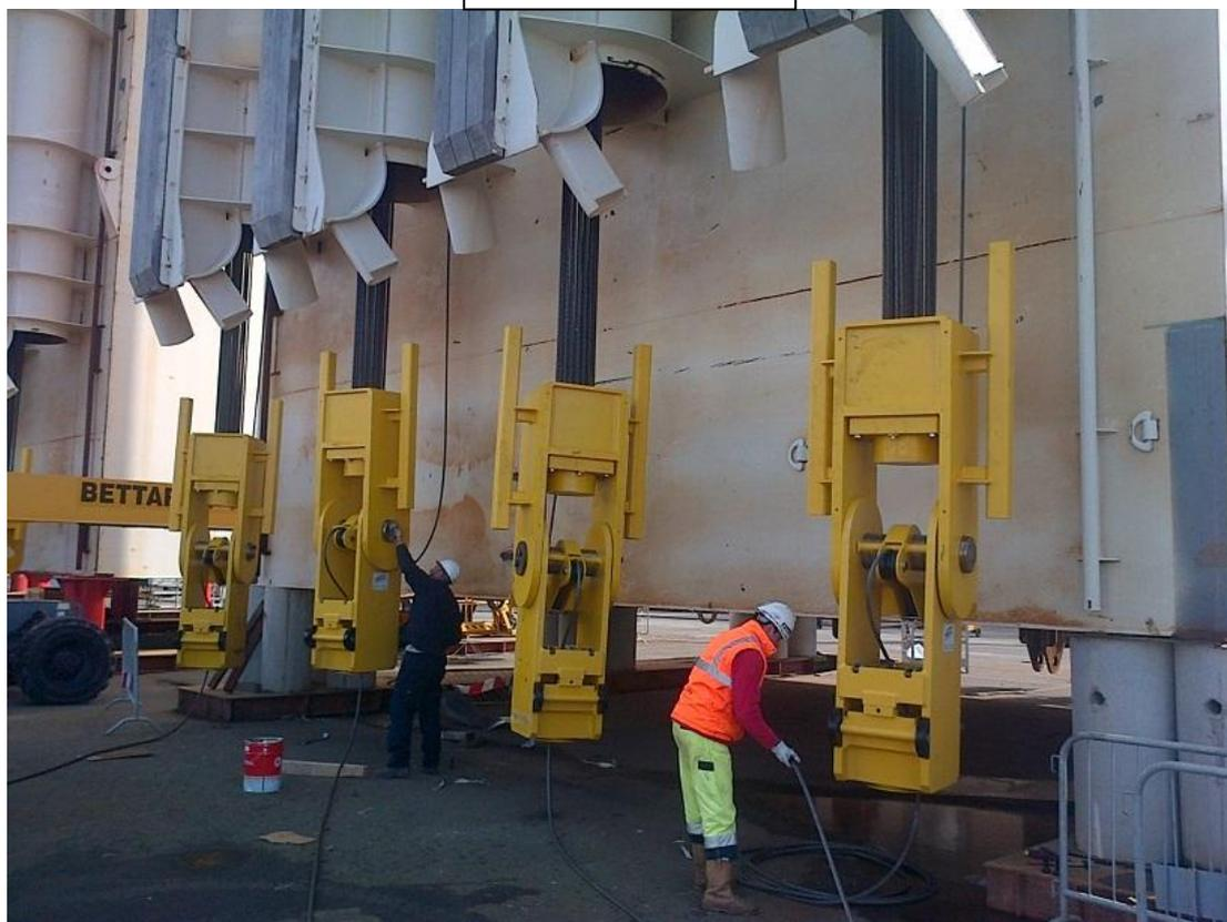
*Sopra: Collegamento dei “swivels” ai “link plates” del cassone S11 nel cantiere di Livorno
