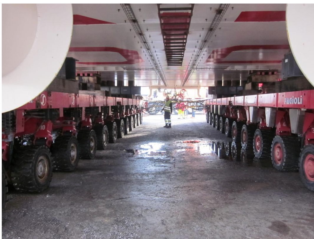
Preparazione del cassone di spinta S12 per la rotazione
