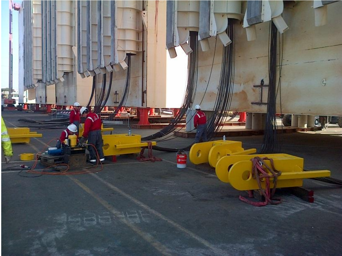
Sopra: installazione "link plates" sul cassone S11 presso il cantiere di Livorno Sotto: "swivel pin" da collegare alle catene in preparazione al rigalleggiamento
