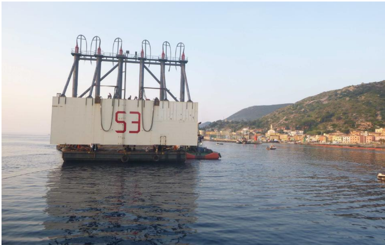
Sopra: cassone S3 sul pontone Micourier 1 arriva in area di lavoro
