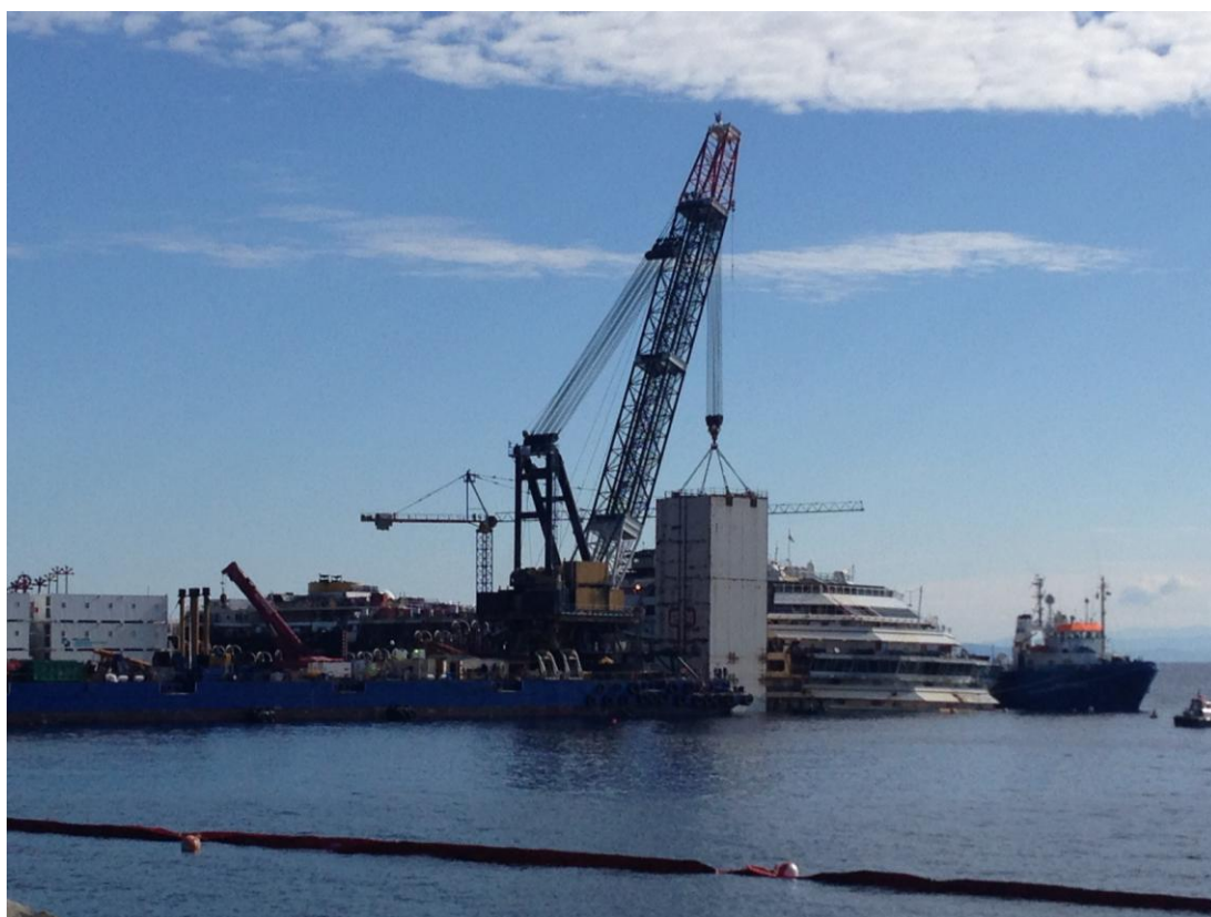
Sotto: installazione del cassone S2
