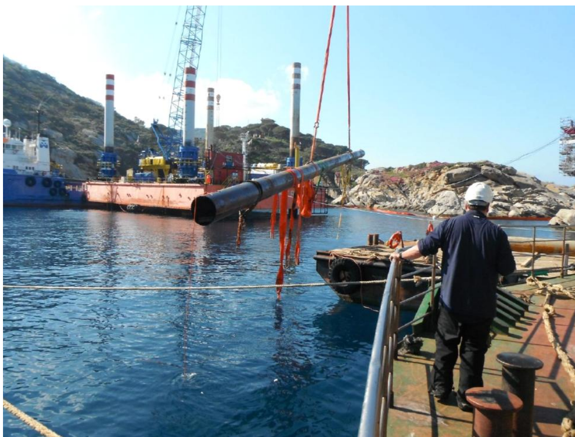
Rimozione sistema di ritenuta di prua
