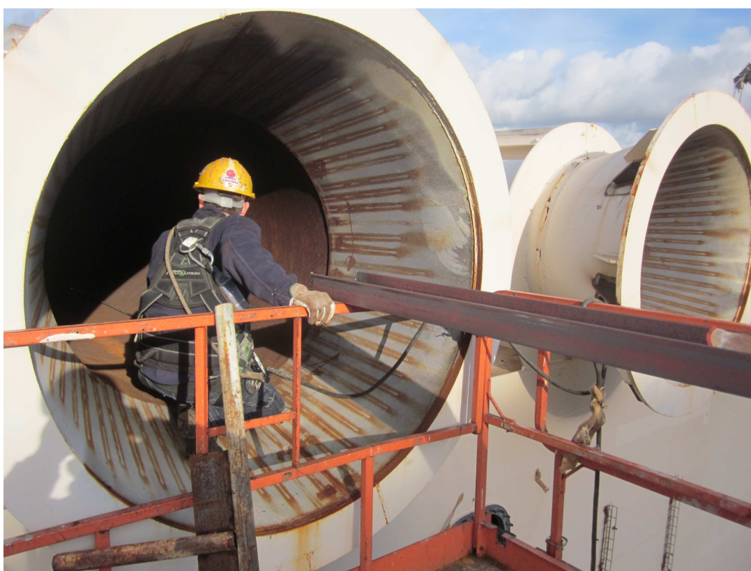
Sopra: equipaggiamento per la rotazione dei cassoni di spinta in arrivo nel cantiere di Livorno Sotto: installazione guide all'interno dei tubi sul cassone S12
