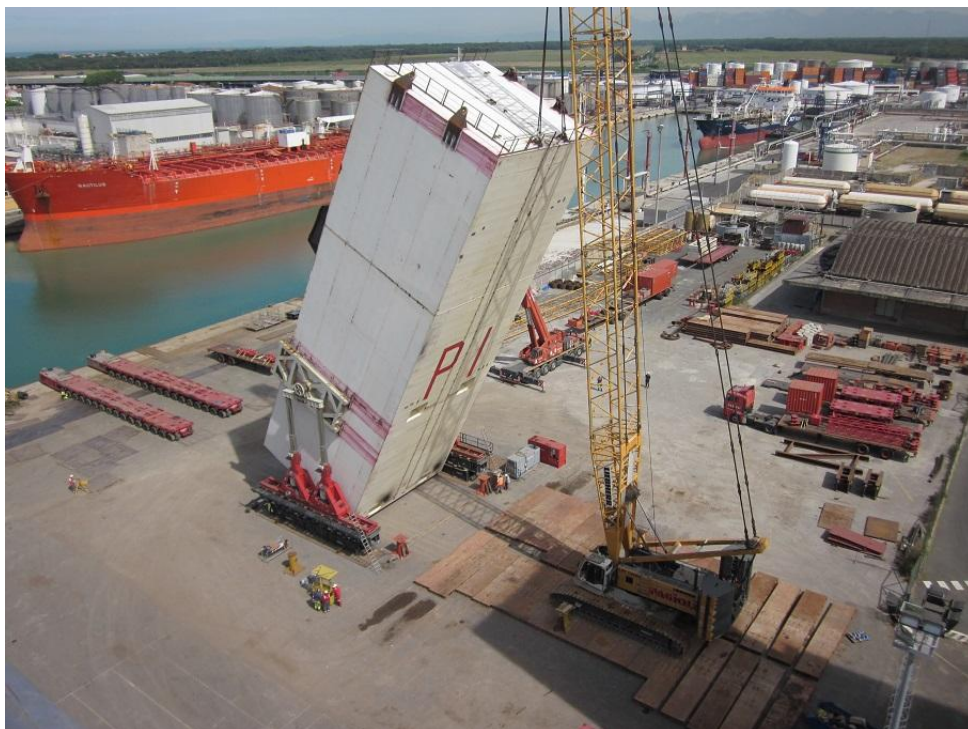
Rotazione del cassone P1 in posizione verticale nel cantiere di Livorno
