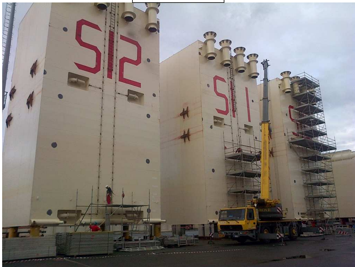
Installazione impalcature sui cassoni di spinta
