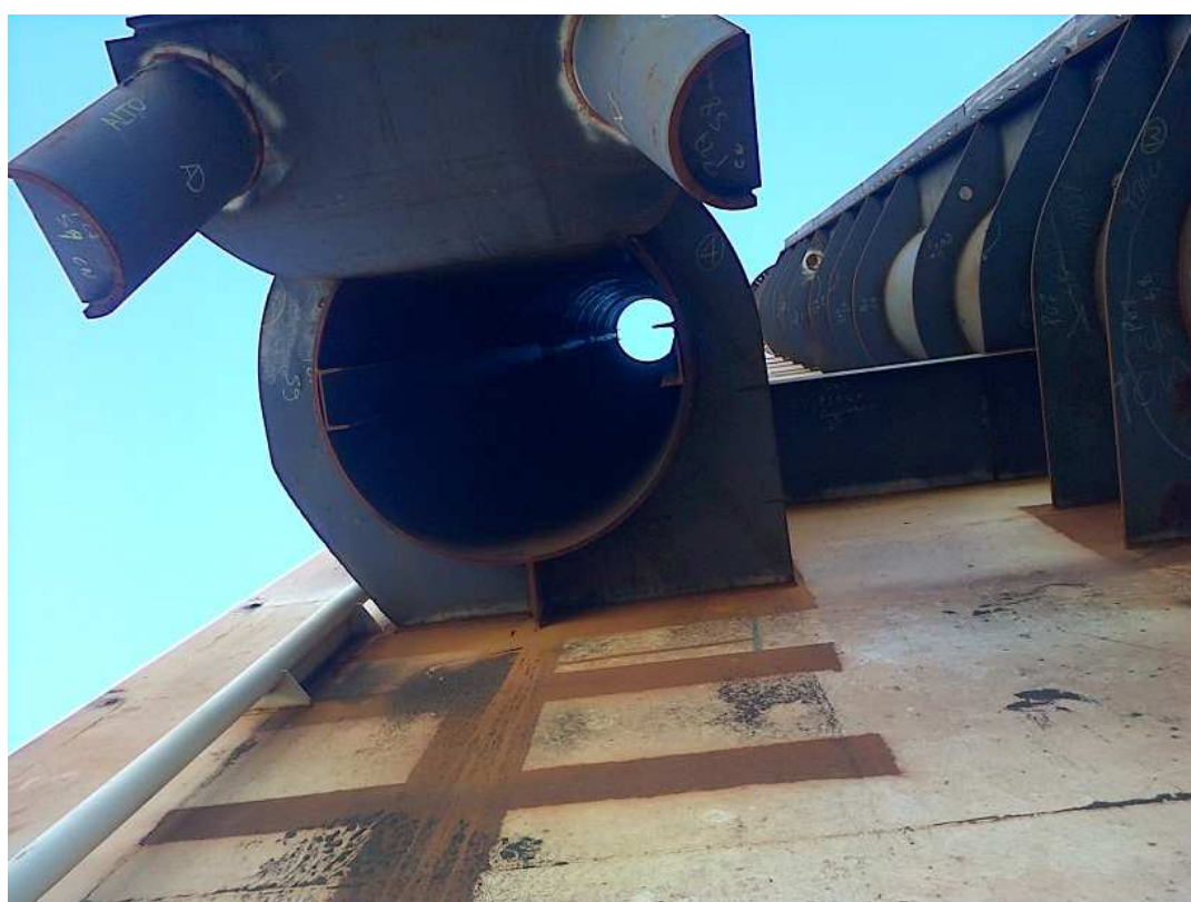
Sopra: rotazione del cassone S9 Sotto: installazione delle guide all'interno dei tubi
