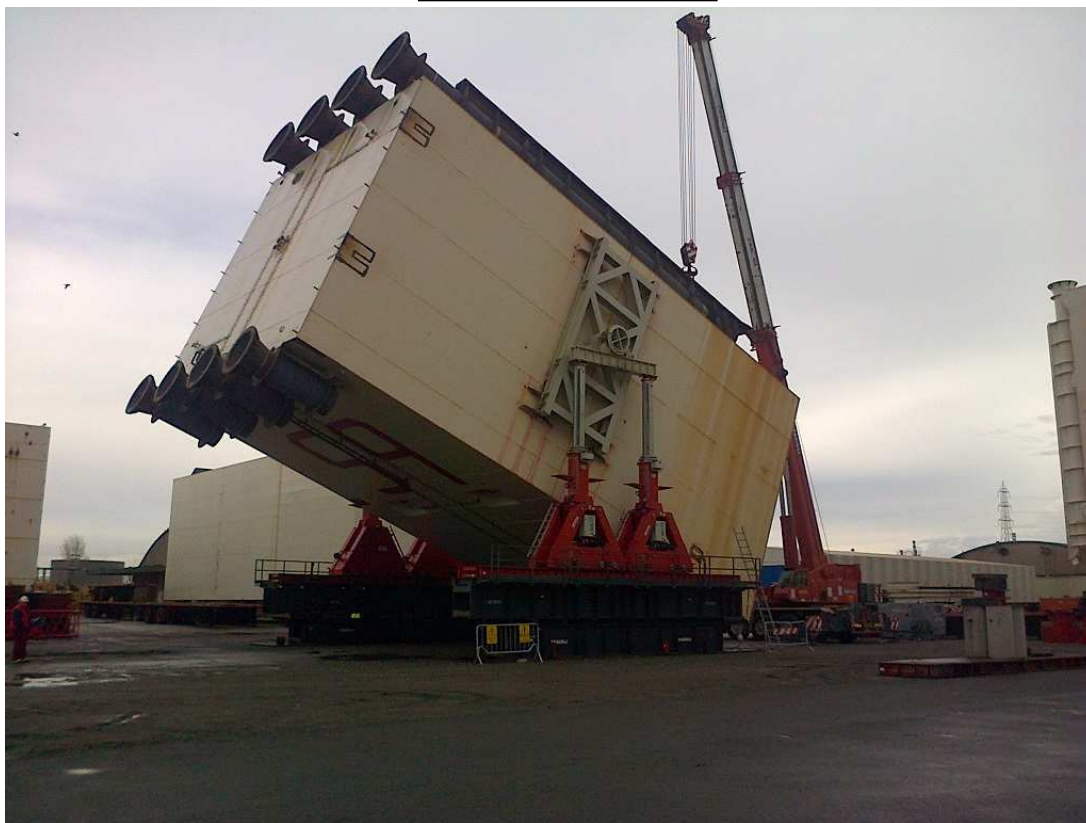
Sopra: rotazione del cassone S9 Sotto: installazione delle guide all'interno dei tubi
