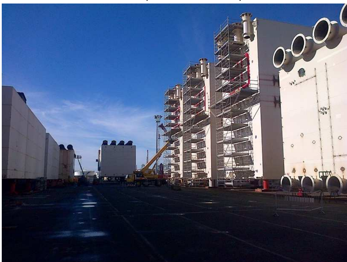
Installazione impalcature sui cassoni di spinta
