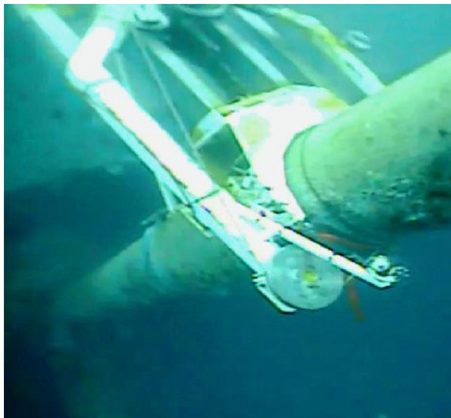
Sopra: Operazioni di taglio dei tubolari della piattaforma 2 Sotto: Installazione cassone S11
