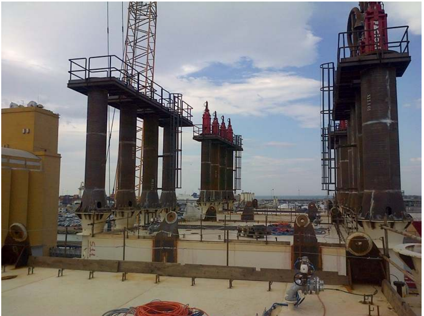
Installazione “extensions” e martinetti sui cassoni S11 e S12.
