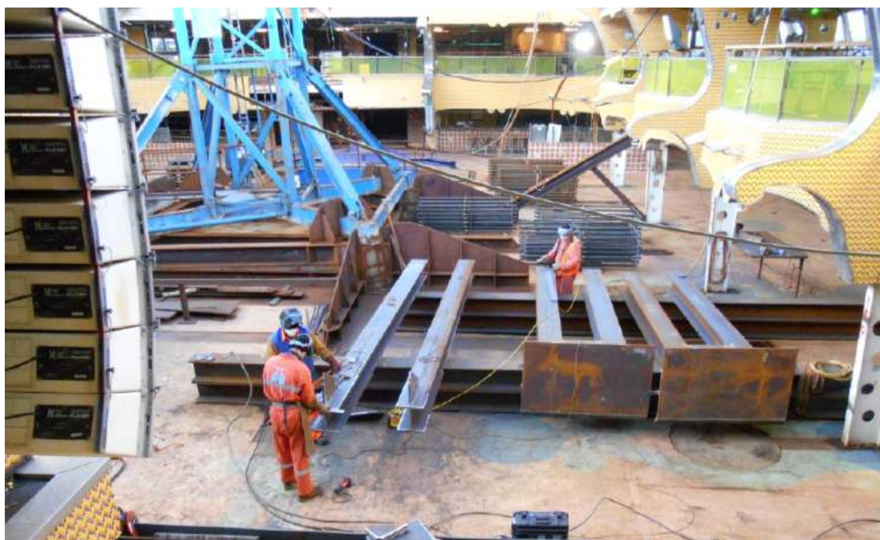
Fabbricazione dei respingenti nel cantiere di Piombino Fabbricazione dei respingenti a bordo della Costa Concordia
