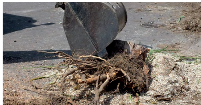
Fig. 13 - Rimozione di tutte le radici appartenenti alla pianta abbattuta
