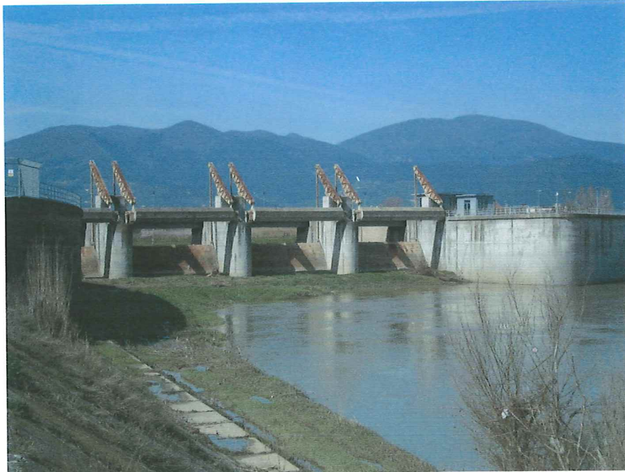
Foto n. 1 - L'Opera di presa vista da monte
